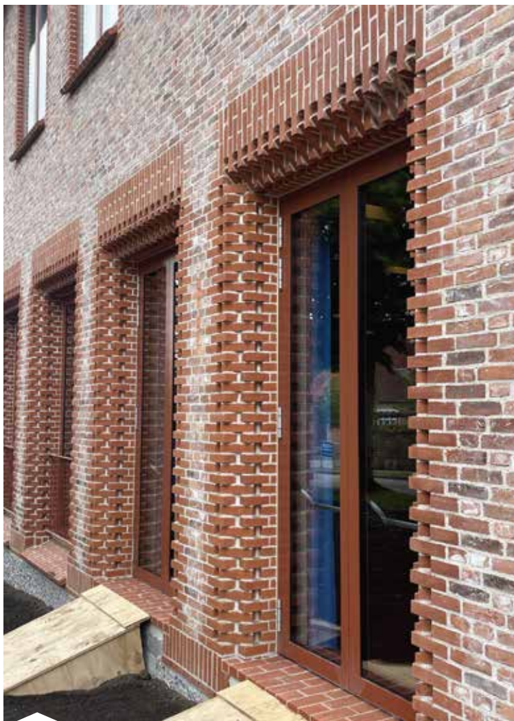
Fælleshuset set udefra. Facaden er beklædt med genbrugstegl fra en nærliggende kirkemur ved Bispebjerg Kirkegård.
